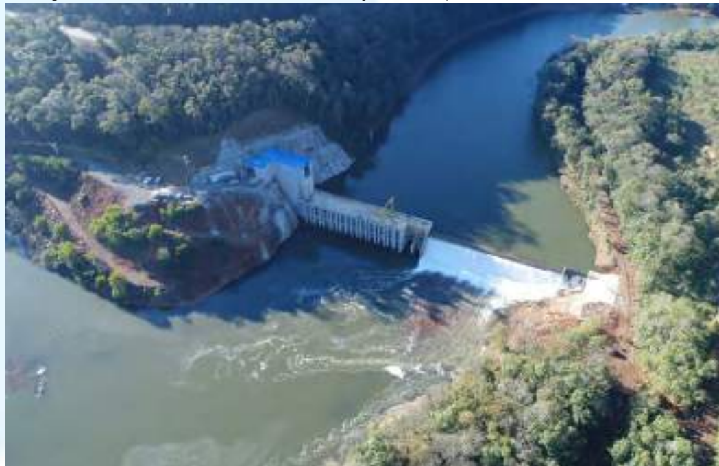
Figura 32 – Barreira artificial em construção do empreendimento PCH Linha Rica.
