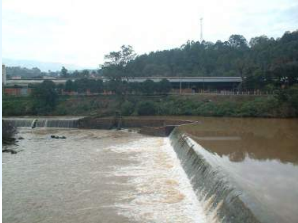
Figura 30 – Barreira artificial com escada para peixes no empreendimento CGH Sopasta I.
