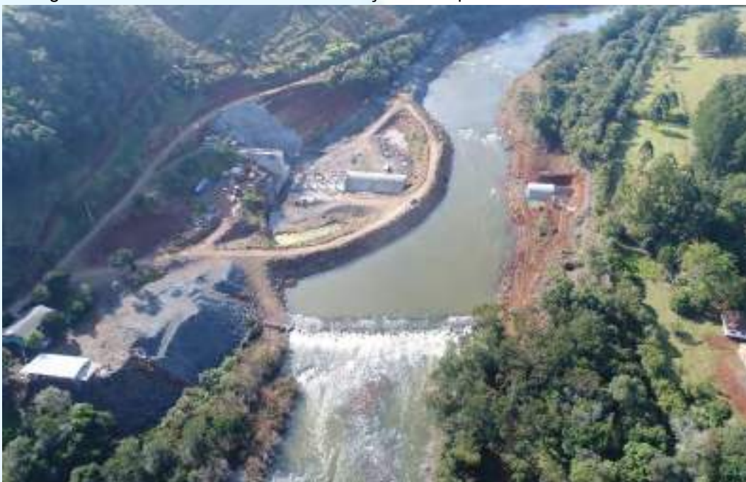
Figura 37 – Barreira artificial em construção do empreendimento PCH São Carlos.
