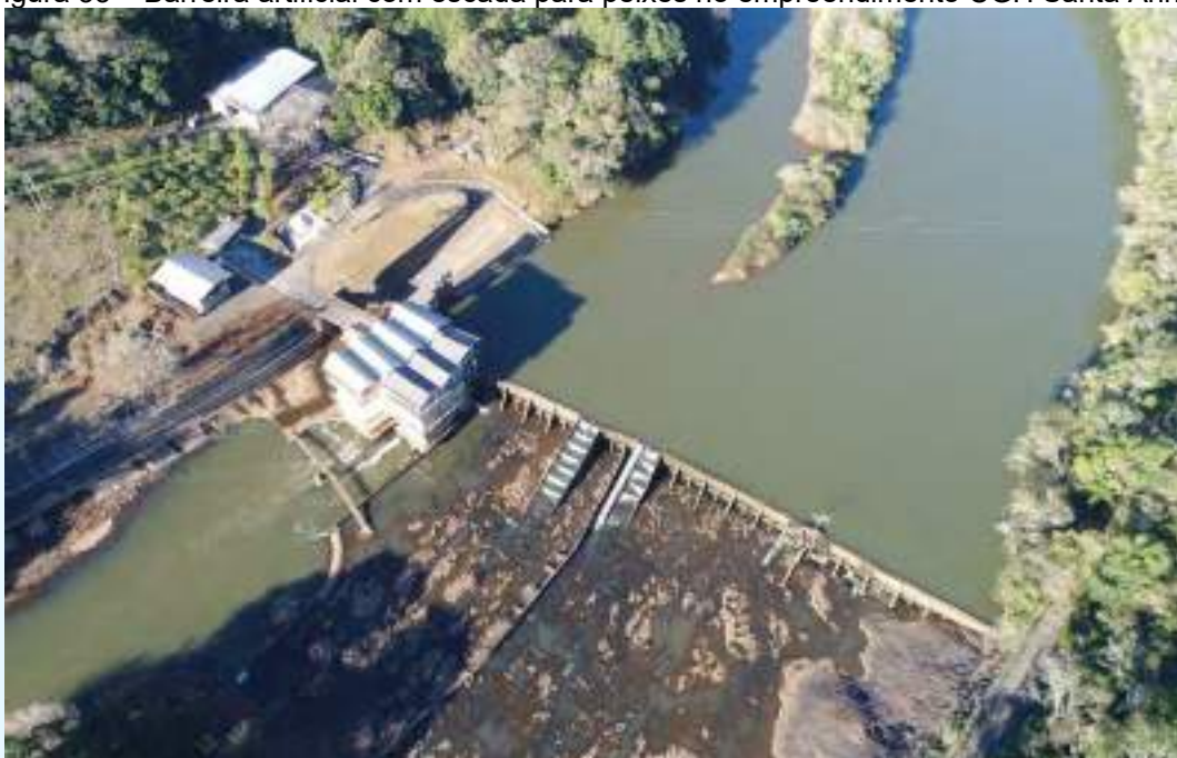
Figura 33 – Barreira artificial com escada para peixes no empreendimento CGH Santa Anna.
