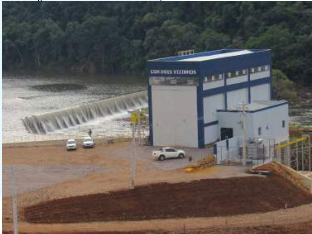
Figura 26 – Barreira artificial do empreendimento CGH Dois Vizinhos.
