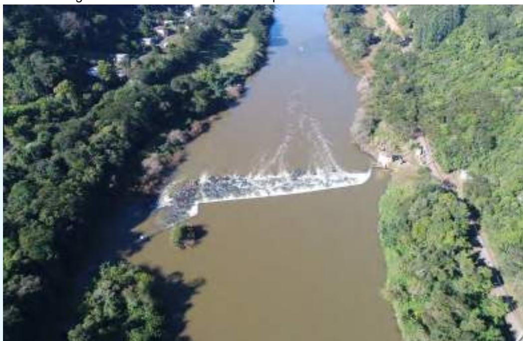
Figura 36 – Barreira artificial do empreendimento CGH Antônio Viel.
