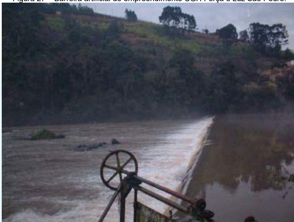
Figura 27 – Barreira artificial do empreendimento CGH Força e Luz São Pedro.
