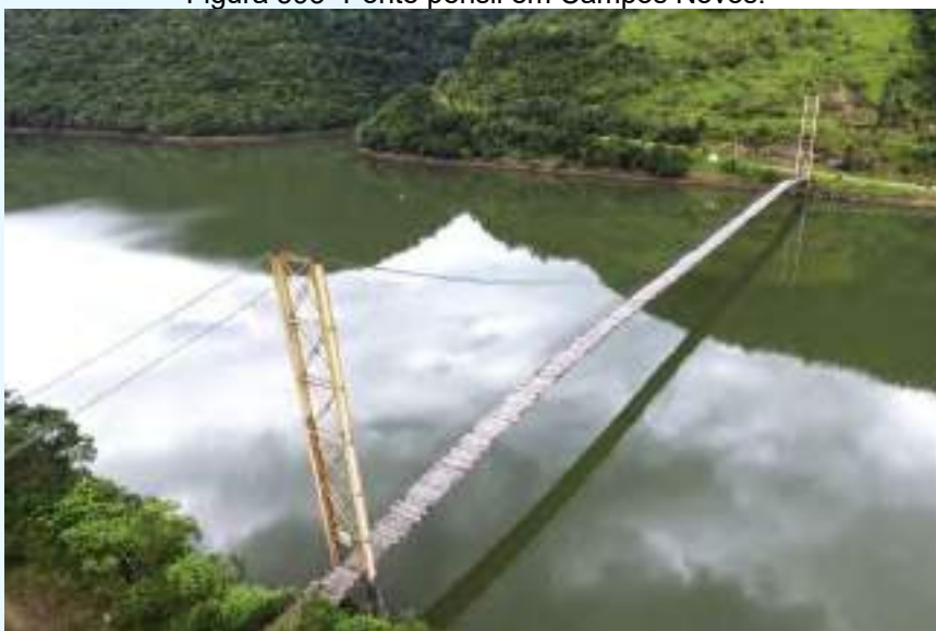
Figura 593- Ponte pênsil em Campos Novos.
