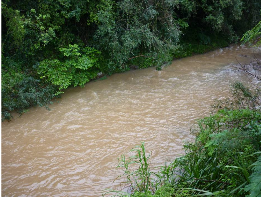
Figura 42: Ponto de estrangulamento na ponte no rio Erval Fonte: Consórcio SOTEPA/IGUATEMI/AR
