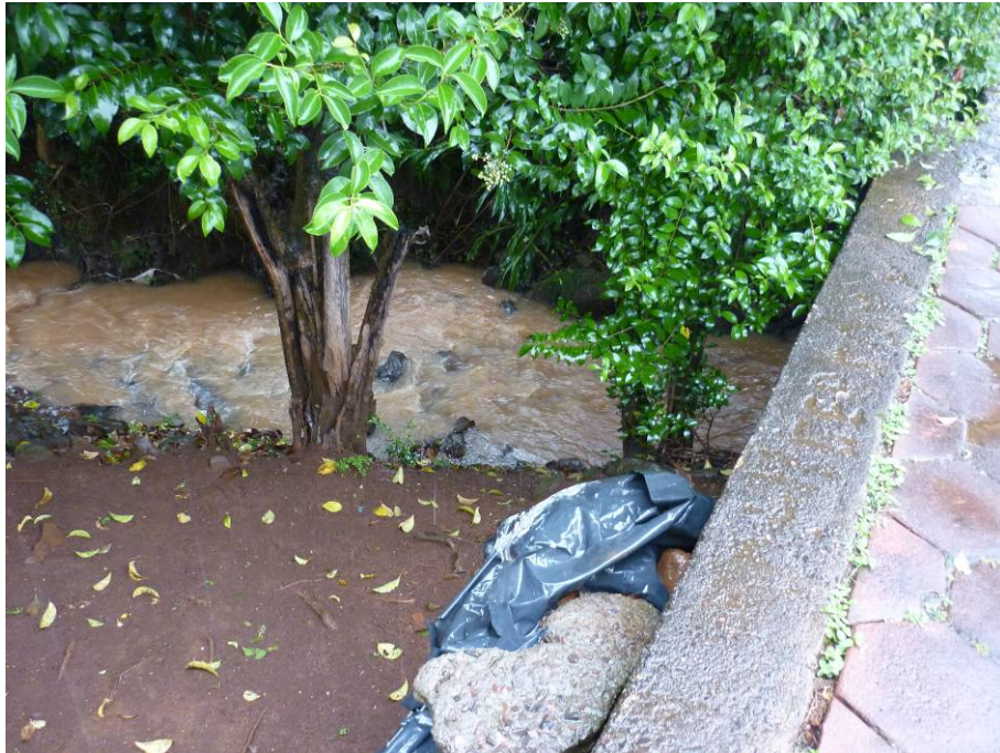
Figura 45: Confluência de tubulações de drenagem e ponto de estrangulamento no Rio dos Micos
